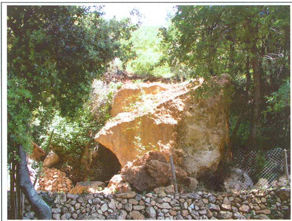
Photographie 4. Morceau de sol qui a glissé en aval du quartier « Le Camp ».
