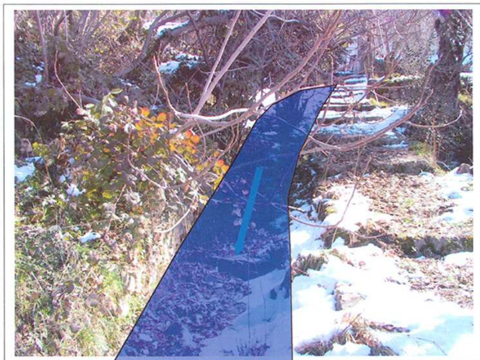
Photographie 9. Ecoulement des eaux du vallon des Templiers sud, en aval de la maison ; en bleu : canal à consolider.
