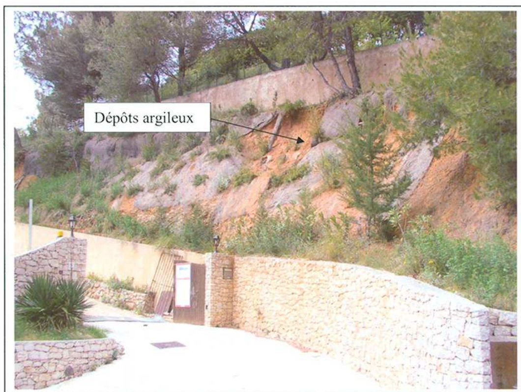
Photographie 5. Dépôt superficiel argileux favorisant des glissements de type superficiel.
